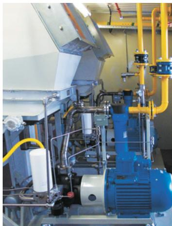
*Рис. 3. Два дожимных компрессора COMPEX 18 в климатическом исполнении на Боголюбовском нефтяном месторождении, Оренбургская область*
