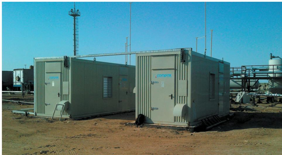
*Рис. 4. Дожимные компрессоры COMPEX 110 для компримирования попутного нефтяного газа на месторождении «Сарыбулак» в Казахстане*
