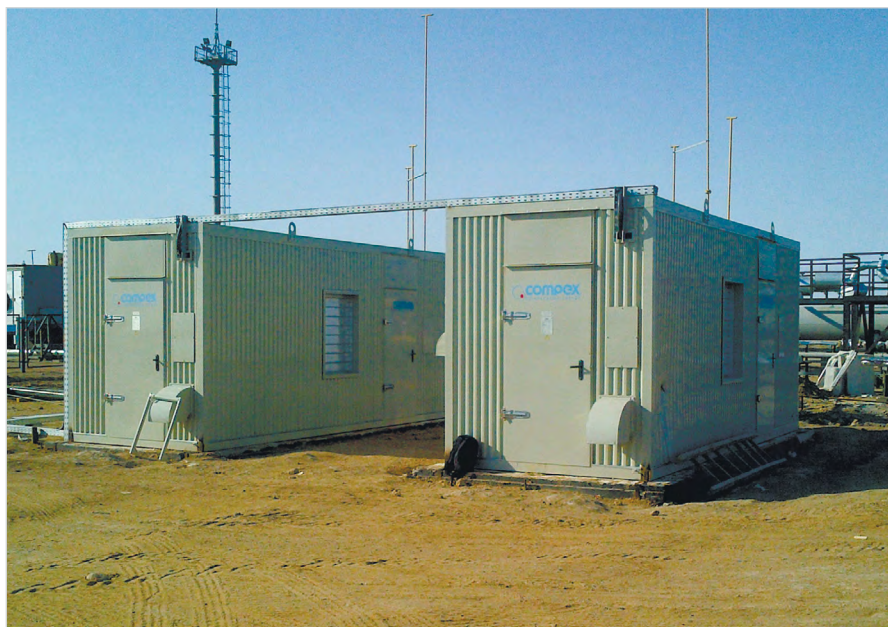
Дожимные компрессоры COMPEX 110 для компримирования попутного нефтяного газа на месторождении «Сарыбулак» — в Казахстане
