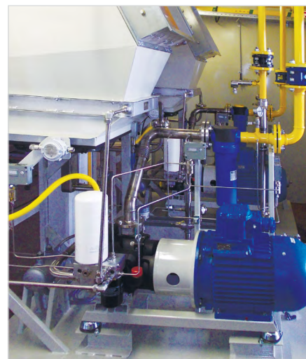
Два дожимных компрессора COMPEX 18 в климатическом исполнении на Боголюбовском нефтяном месторождении, Оренбургская область
