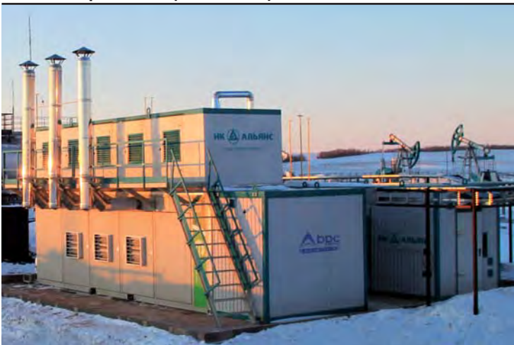
Рис. 6. Мобильная микротурбинная электростанция на месторождении ООО «ЛУКОЙЛ-ПЕРМЬ»
