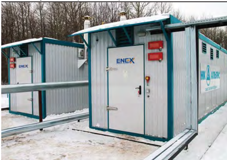
Рис. 3. Микротурбинный энергоцентр УПСВ «Усаево» ОАО «Татнефтеотдача» (НК «Альянс»)
