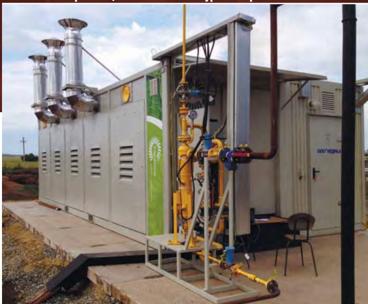
Рис. 2. Применение микротурбин на Онбийском нефтяном месторождении ЗАО «ТАТЕХ»
